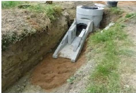
Figure 2 Aménagement du lit du cours d'eau et conduite eau pluviale
